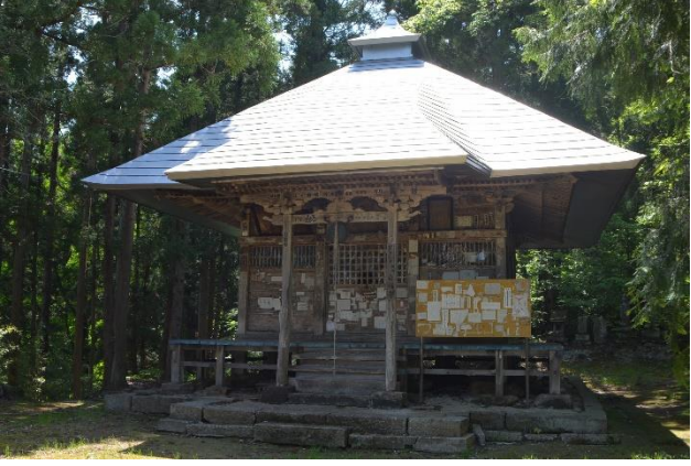
堂東下に駐車。集落内道路狭し。
