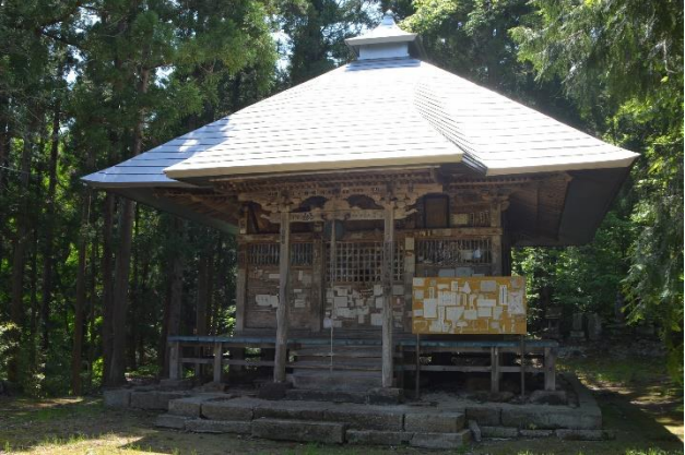
堂東下に駐車。集落内道路狭し。
