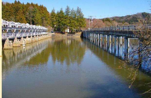
猪苗代湖、戸ノ口堰の取入れ口にある十六橋。戊辰戦争の激戦地。郡山の開拓に貢献した安積疎水の水位調整をしている。
