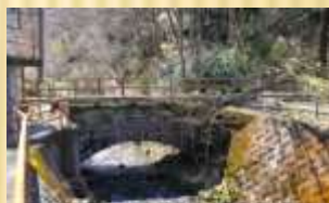
戸ノ口堰水道橋
